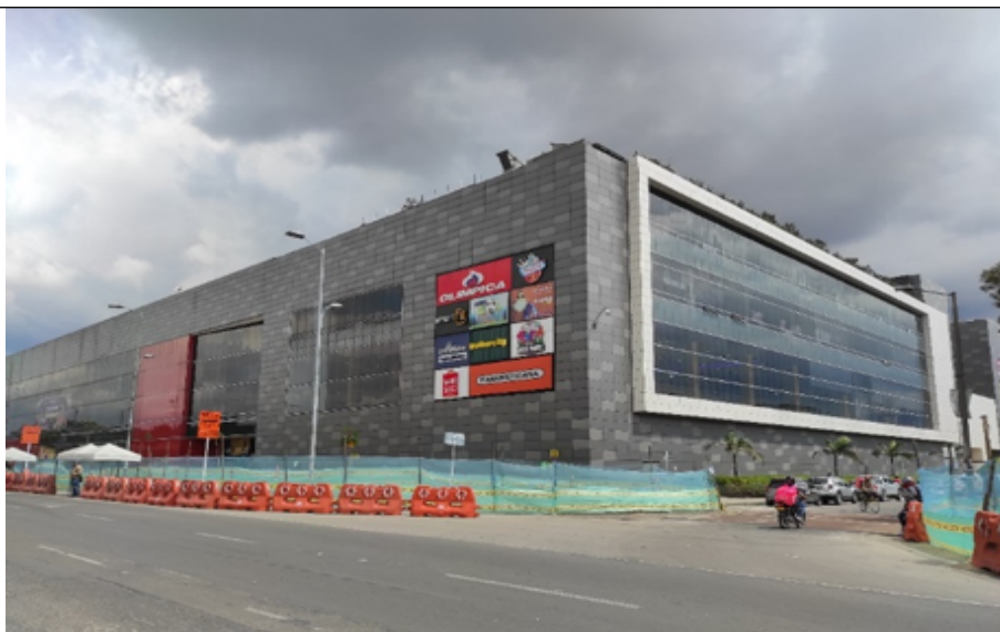
Foto 1. Vista panorámica del lote ubicado en la Av. Carrera 68 No. 75 A - 50 (dirección catastral), donde se evidencia que el elemento de Publicidad Exterior Visual, tipo valla con estructura tubular, fue desmontado totalmente del lugar.
